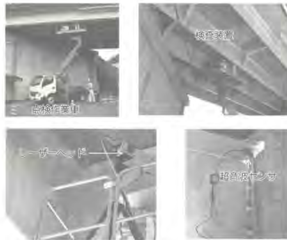
第8図 鋼橋検査の様子
