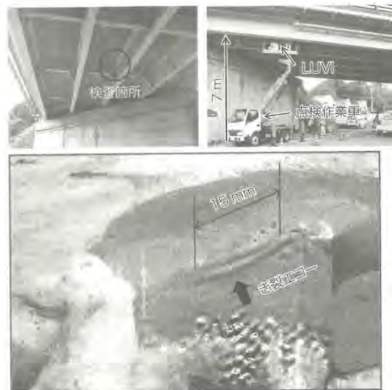
第7図 鋼橋溶接部の疲労亀裂検査
