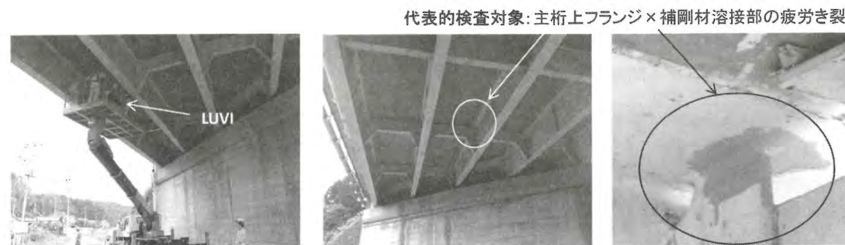
図 9 福原第二跨道橋（国道 50 号）検査部位
